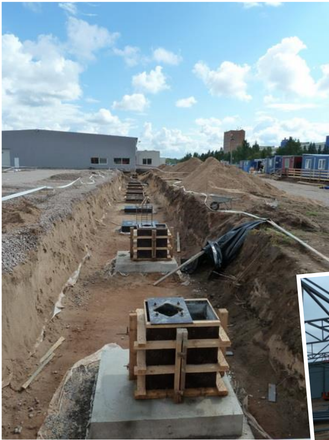
Установка фундамента и каркаса
