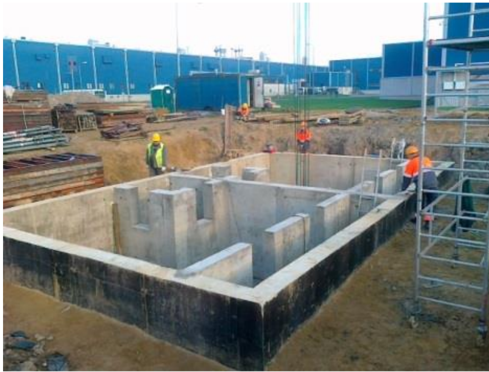
Строительство очистных сооружений ливневых стоков
